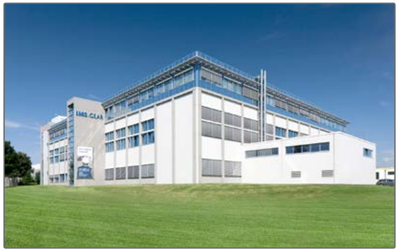
Das IMS Gear Technikzentrum in Donaueschingen.
